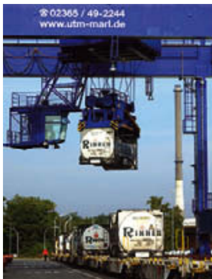
CHEMIEPARK MARL: Umschlagterminal mit Bahnshuttle zum Duisburger Hafen.
