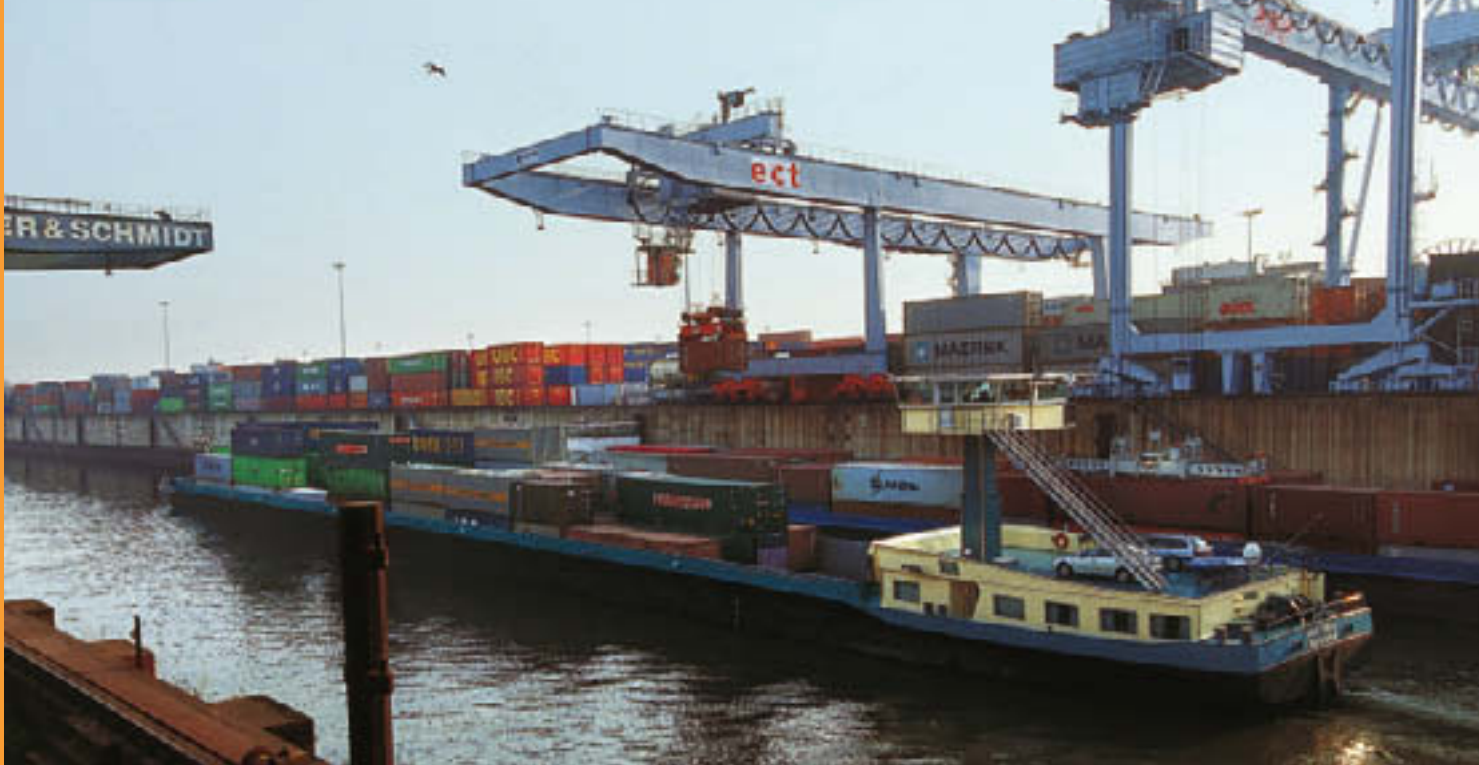
DUISBURG: Europas größter Binnenhafen glänzt mit guten Wasserverbindungen sowie zahlreichen Autobahn- und Gleisanschlüssen.
