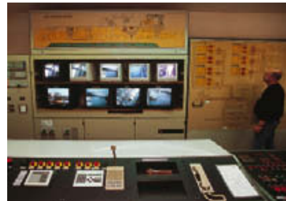
SICHERHEIT: In der Schaltzentrale der Ölinsel werden alle Chemie-Bereiche regelmäßig kontrolliert.
